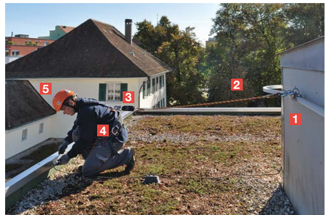
Bild 11 Rückhaltesystem auf einem Flachdach
