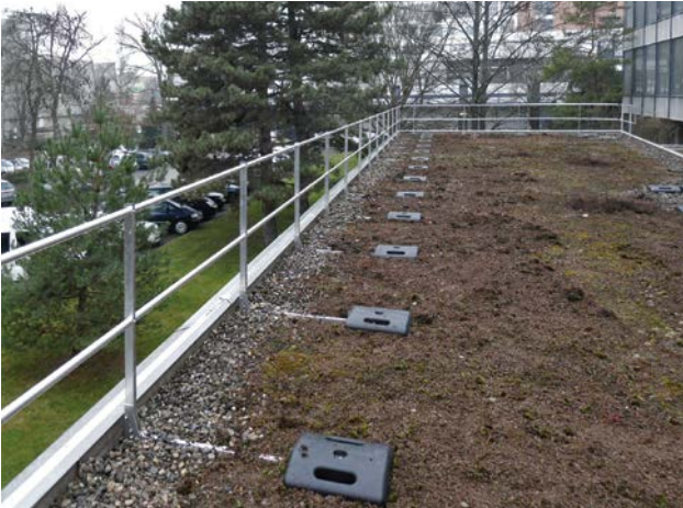
Bild 1 Kollektivschutz bietet optimale Sicherheit am Dachrand
